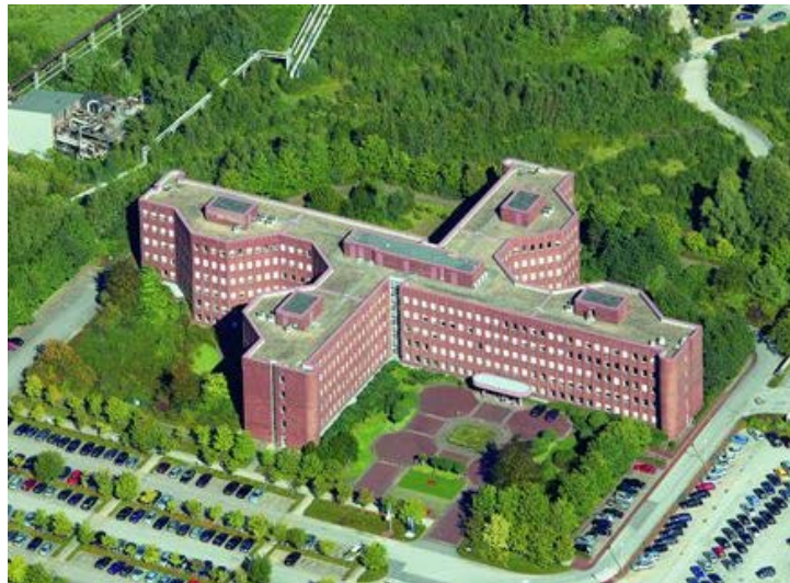
Figure 4-25 ThyssenKrupp Kreuzgebäude in Essen, Germany
