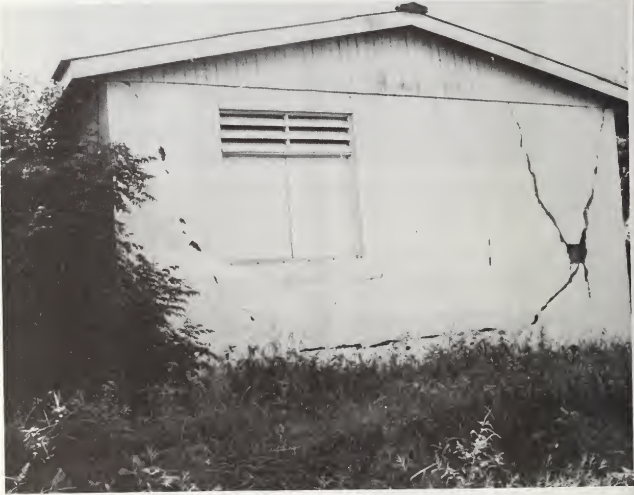
Figure 36: Colonia 14 de Septiembre, concrete block house with flexural cracking.
