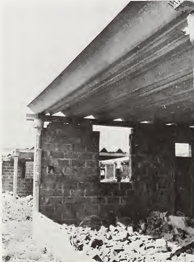
Figure 38: Viviendo de mi Hermano, collapsed walls.
