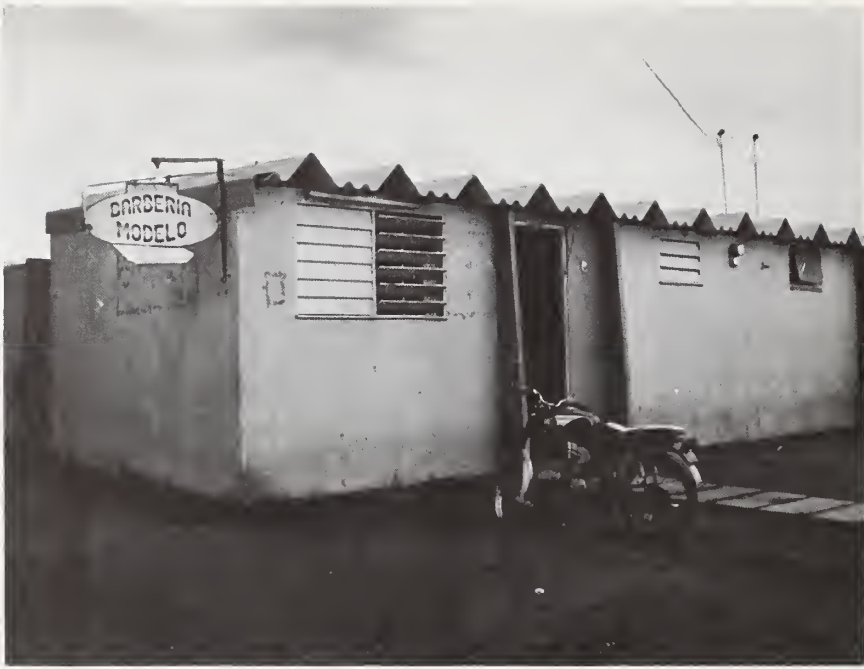
Figure 43: Primero de Mayo, units show no damage.
