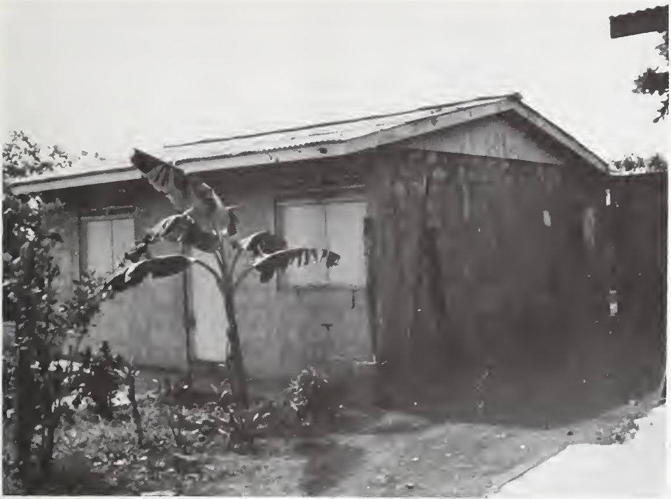
Figure 34: Colonia 14 de Septiembre, concrete block house with light damage.
