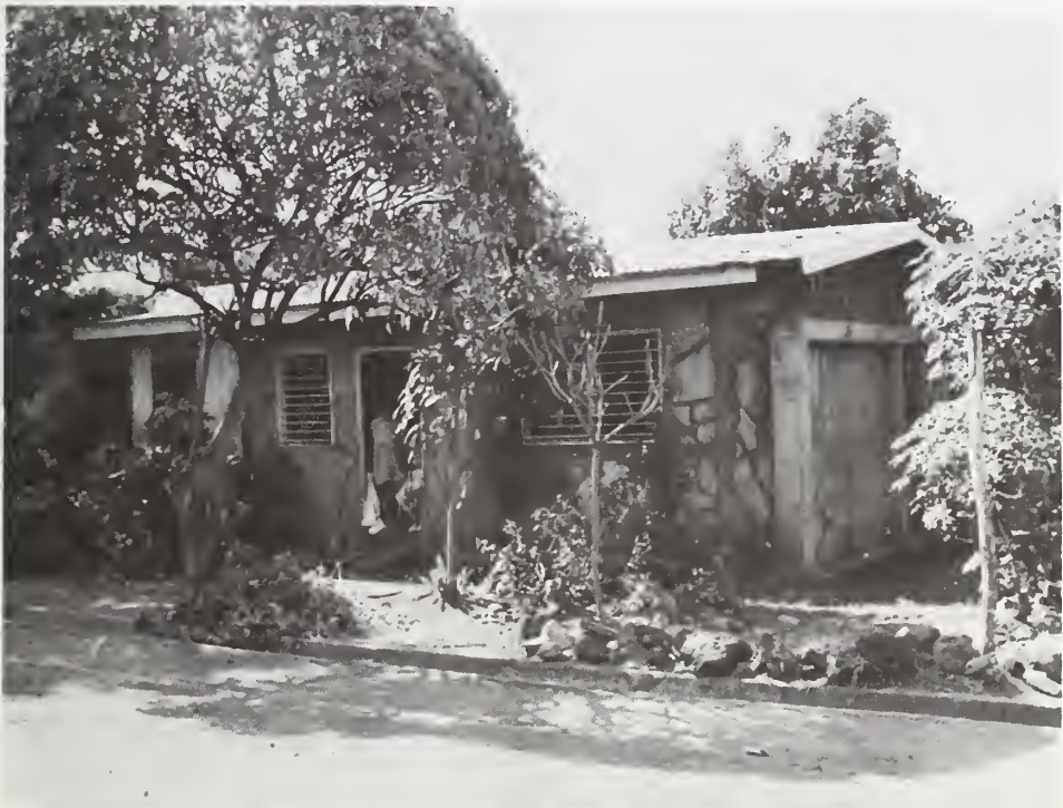
Figure 35: Colonia 14 de Septiembre, cracked and repaired house of type like Maximo Jerez.
