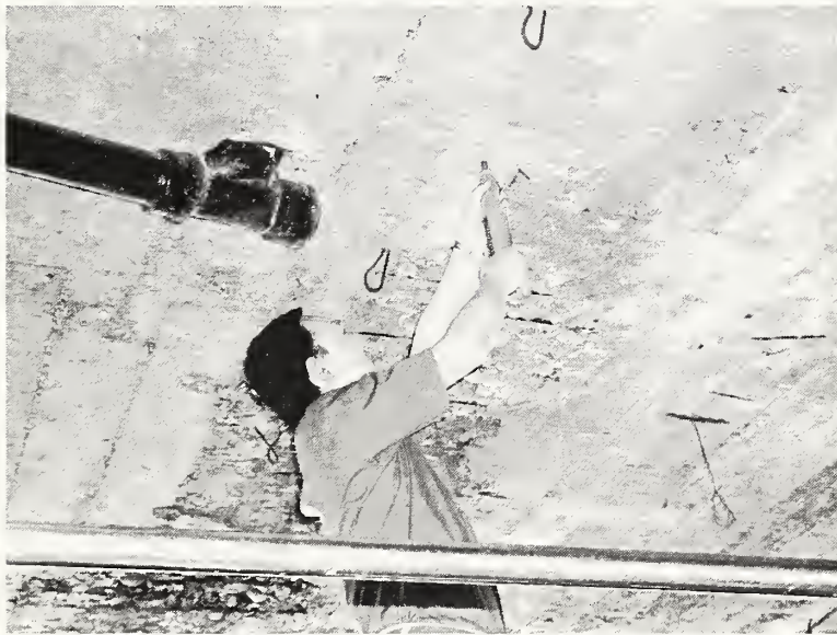
Parte inferior de la losa del segundo piso
